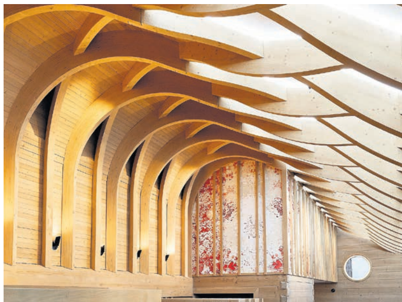
Le respect des principes du développement durable était au centre des travaux de construction du Huus Quell.
