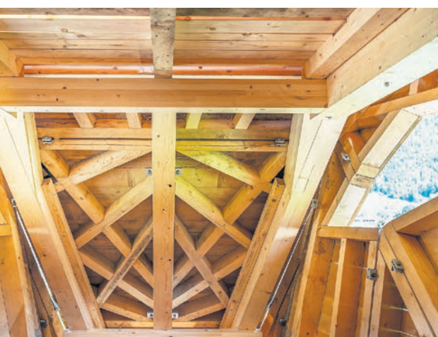
La construction du front depuis l'intérieur.
