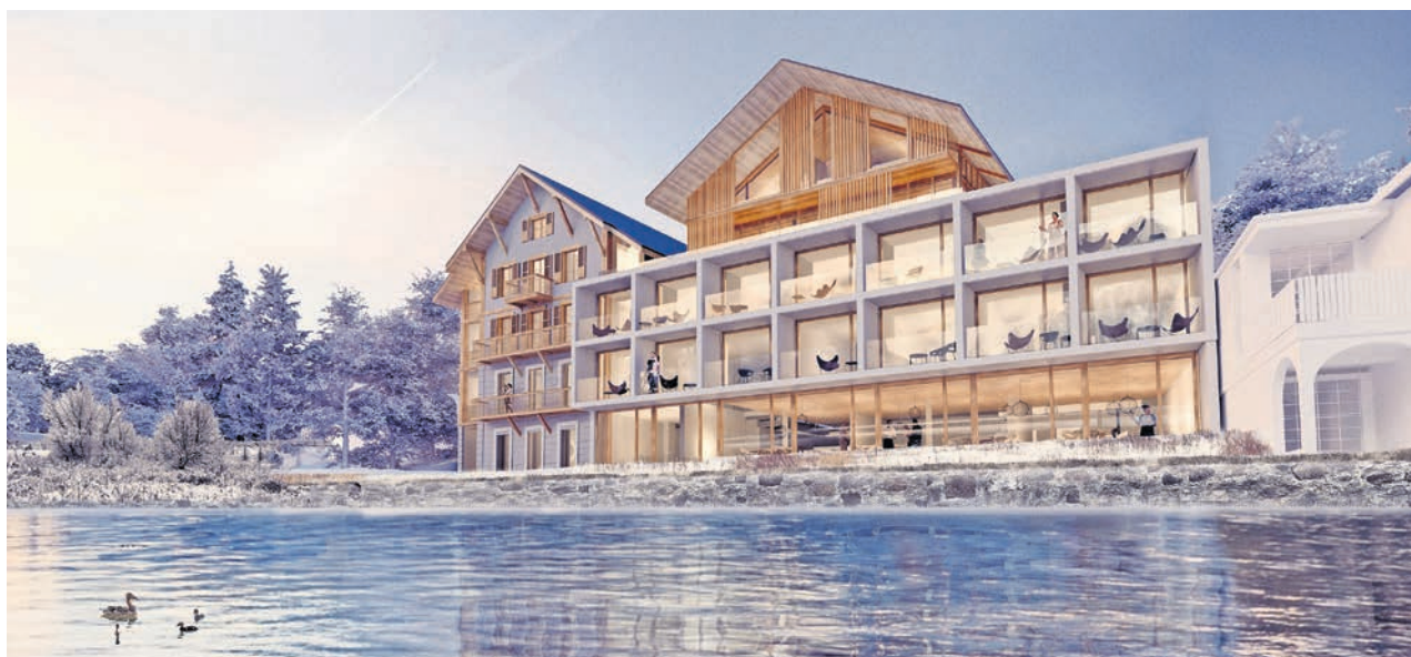
Le futur Hôtel-restaurant Du Lac depuis le lac: les bâtiments existants des années 1970 (à droite) et de 1900 seront complétés par un bâtiment en bois.
